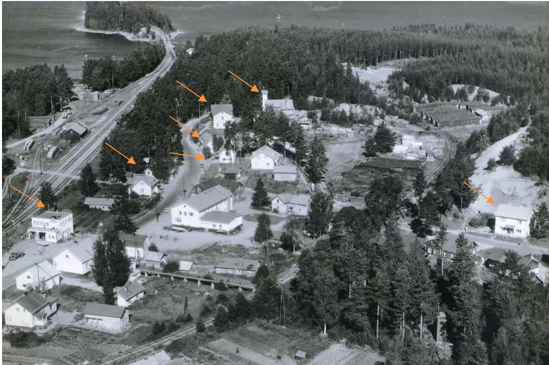
Kuva: Punkasalmen kirkonkylän keskustaa ennen valtatie 14:n rakentamista. Edelleen olemassa olevat keskustan talot on osoitettu nuolilla.
