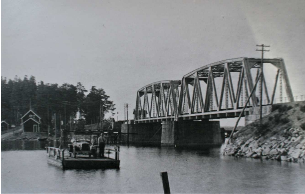
Kuva: Vanha 1906 rakennettiin rautatiesilta. Autot joutuivat ylittämään salmen lossilla ennen kuin sillasta tehtiin yhdistetty rautatie- ja autosilta 1935. Nykyinen teräsrakenteinen kaarisilta on vuodelta 1976. Se palkittiin kansainvälisen teräsrakennejärjestön ECCS toimesta. 11 /Yrjö Tukiaisen valokuvakokoelma.
