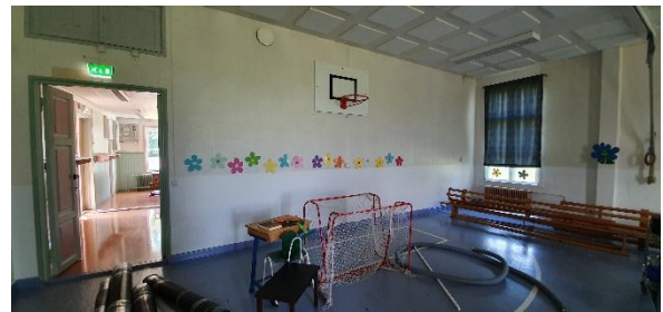
liikuntasali, ei havaittu asbestia
