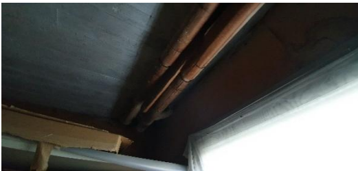
Alakerran varaston putkieristeet, sisältävät asbestia
