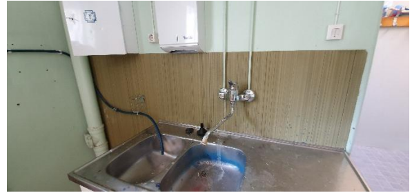
puutyöluokan seinä, ei havaittu asbestia
