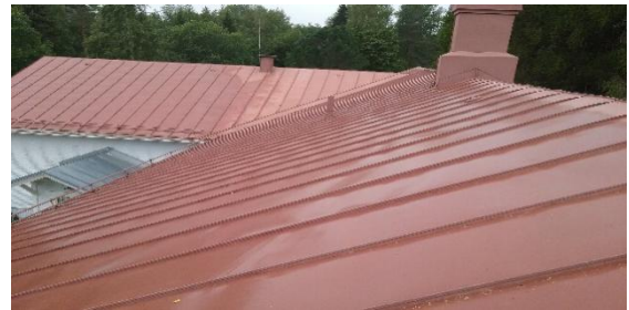
vesikattomaali, ei havaittu asbestia (näyte 12)
