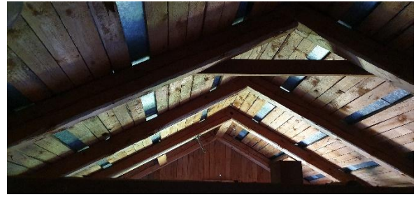
vesikaton alapuoli, ei havaittu asbestia
