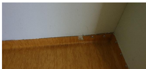
kellarin wc:n lattiamatto, ei havaittu asbestia (näyte 2)
