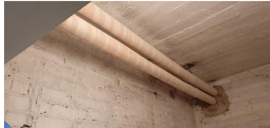
Alakerran varaston putkieristeet, sisältävät asbestia
