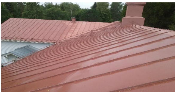
vesikattomaali, ei ylitä raskasmetalliraja-arvoja (näyte 12)
