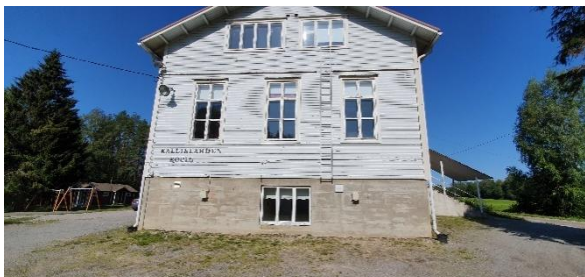
julkisivumaali, ylittää raskasmetalliraja-arvot (näyte 1)
