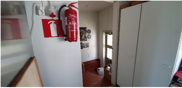
tuulikaappi 112, portaiden maali, ei havaittu asbestia (näyte 11)
