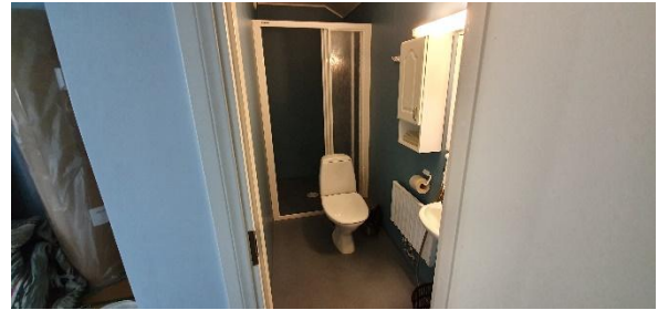
ullakkokerros wc/suihku, ei havaittu asbestia
