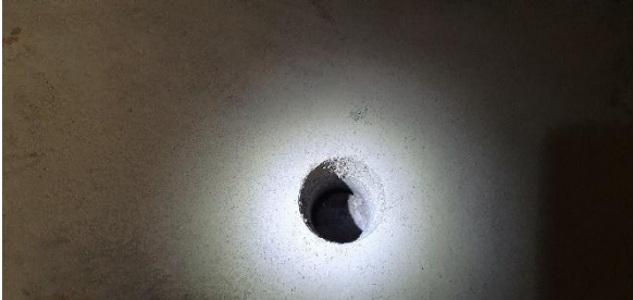
(näyte 2), valokuva, kellarikerroksen poranäyte kaatopaikkakelpoisuuden selvittämiseksi
