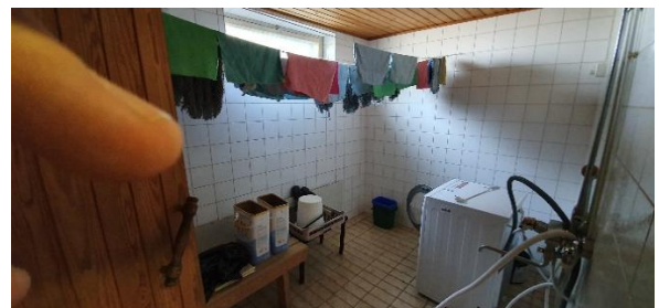
kellarin pesuhuone, laatan kiinnitys- ja sauma-aineet, ei havaittu asbestia (näyte 7 ja 8)
