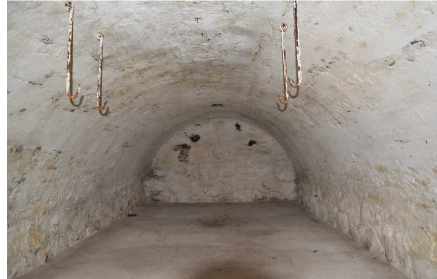
Kuva: Kellari on 12 m pitkä, 5 m leveä ja 3 metriä korkea. Muurausta on vahvistettu ohuella betonivalulla (lautamuotti).
