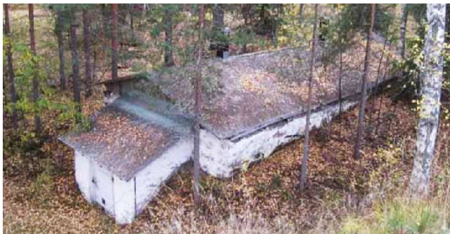
Kuva vasemmalla: Ruukin ajoilta peräisin oleva kivikellari. / Kuva Seppo Lamppu.
