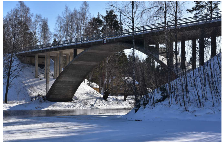
Kuva: Tielaitoksen teettämässä betonisillan korjauksessa 2003–2004 uusittiin pintarakenne, reunapalkki ja sillan kaide sekä pinnoitettiin holvi.
