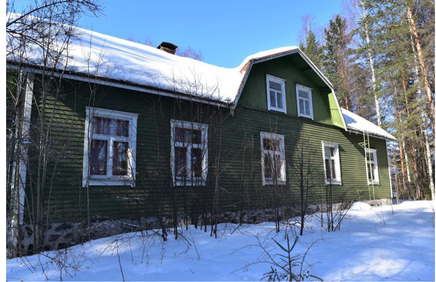
Kuva: Puistoniemen talon julkisivu kanavan suuntaan. Piha-alueella on jäljellä istutettuja hedelmäpuita, mutta pääosin ympäristö on luonnontilainen. Viime vuosisadan alkupuolella talon lähiympäristö oli avoimempi ja siellä oli nykyistä enemmän lehtipuita. Etupihalla on vielä iäkkäitä koivuja muistona vanhoista koivukujista, ja koillisosassa tonttia on metsälehmäksiä.
