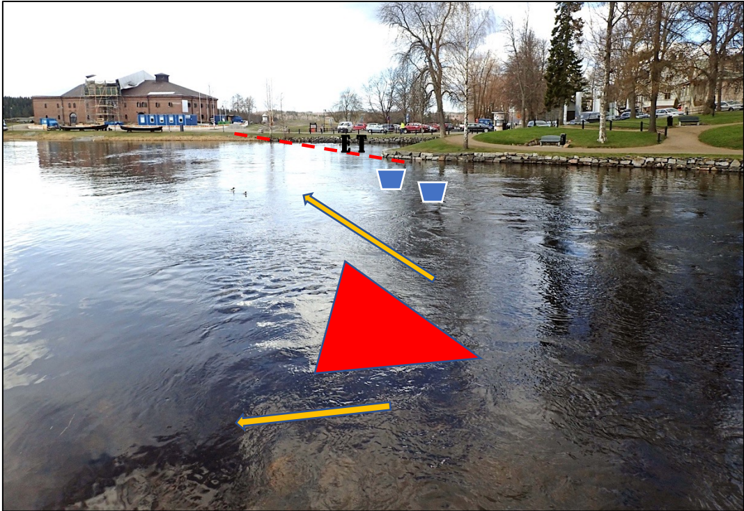
Liitekuva 7. Länsisalmen keskiosa Riihisaaren museon (taustalla) suuntaan. Punainen kolmio kuvaa keskivirran kivistä ohjainsuistetta. Punaisen katkoviivan takaiseen lahdekkeeseen (= Länsisalmen alkuperäinen, myöhemmin täytetty uomaalue) ei tehdä toimenpiteitä. Matalan ja syvän reunaan sijoitetaan kaksi kookasta ja pintaan ulottuvaa näkölohkarettä (sinikuvio).
