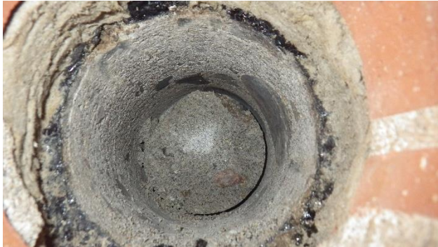
Kuva 8. Pikisivelykerros betoniseinän sisäpinnassa.
