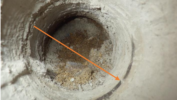
Kuva 28. Alapohjarakenteena kellarissa kaksoislaatta, jonka välissä pikisively.
