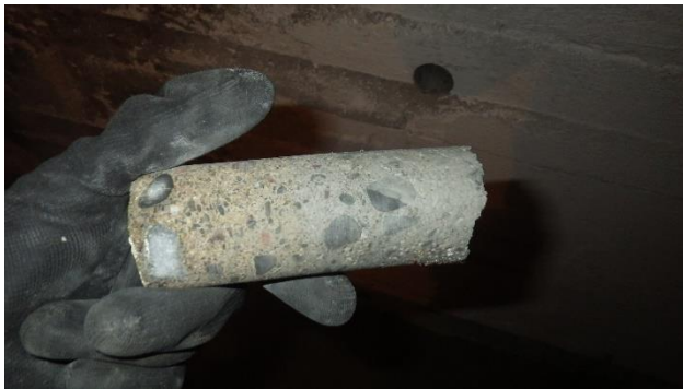
Kuva 19. Rakenne pelkkää teräsbetonia.
