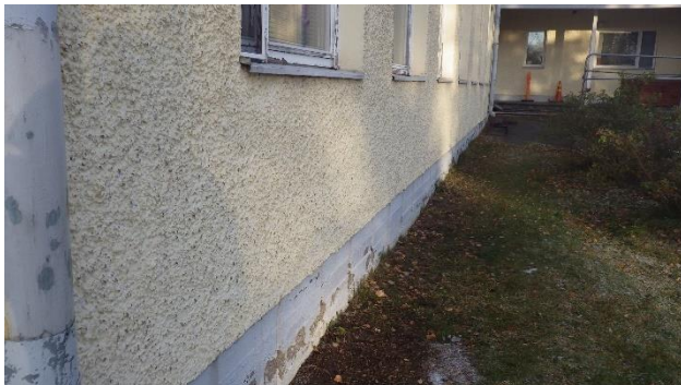
Kuva 19. Ulkoseinät rapattuja tiilirakenteita.
