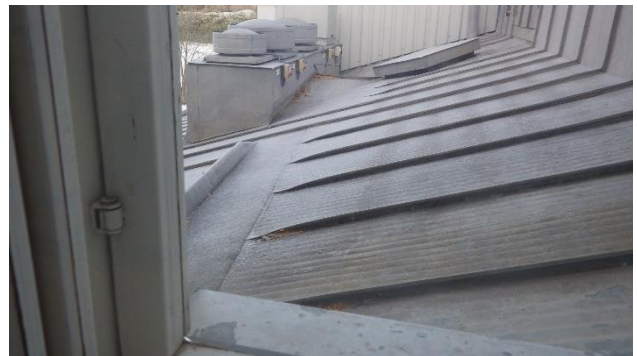
Kuva 55. Vesikattoja päästiin tarkastamaan ainoastaan osittain liukkaista olosuhteista johtuen.
