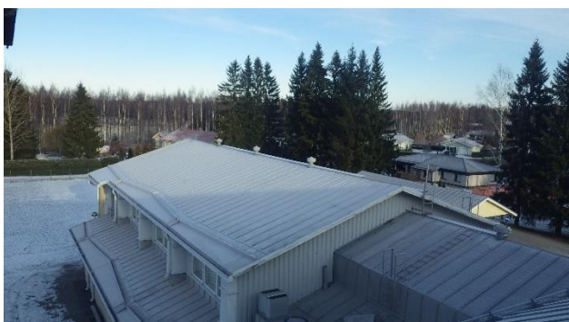
Kuva 62. Liikuntasalin vesikatto on alkuperäinen.
