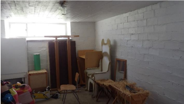
Kuva 22. Maanvastaiset ulkoseinät ovat pääosin tiiliverhoituja, mineraalivillaeristeisiä betoni-rakenteita.
