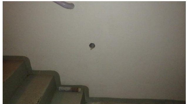
Kuva 20. US-RT7 porrashuoneen sivuseinälle.
