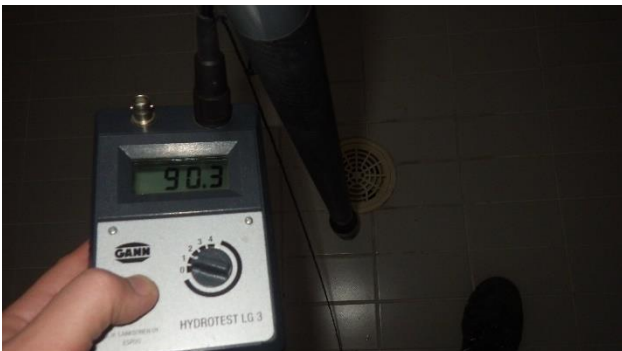
Kuva 40. Pesuhuoneessa pienialaisia kosteuspoikkeama-alueita suihkukaivojen ympärillä. (Mittarin lukema 90,3)
