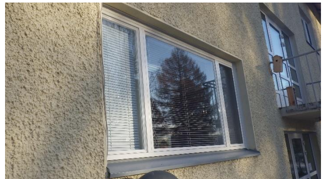
Kuva 22. Kaakkoissiiven ikkunat uusittu vuonna 2012.
