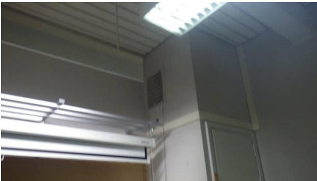
Kuva 66. Lounaanpuoleisessa siivessä painovoimainen ilmanvaihto.
