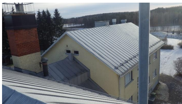
Kuva 63. Yleiskuva vesikatolta, alkuperäisen rakennusosan vesikatto on uusittu vuonna 1987.
