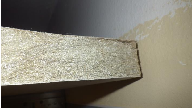
Kuva 98. Mineraalivillaisten akustolevyjen reunat pinnoitettu.
