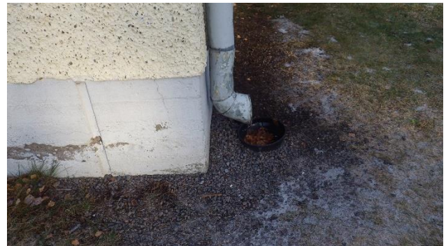
Kuva 6. Sadevedet ohjattu sadevesikouruilta syöksytorviin, josta vedet ohjautuvat sadevesikaivojen kautta pois päin rakenteista.
