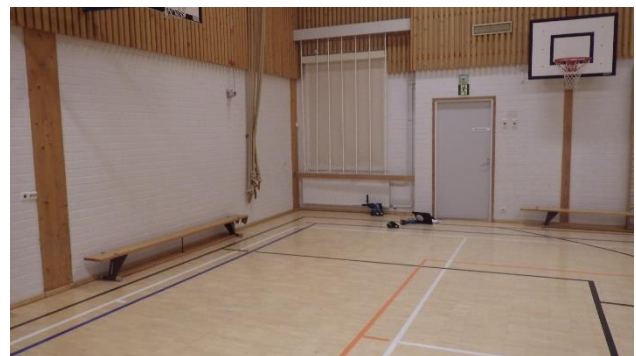
Kuva 91. Liikuntasalissa alkuperäinen parkettilattia.
