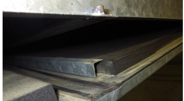
Kuva 81. Siitepölyä suodattimien jälkeen.
