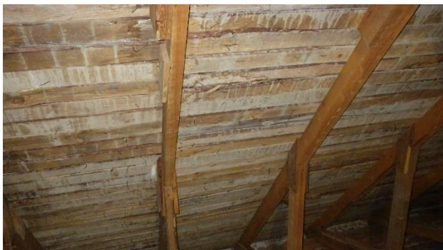
Kuva 58. Umpilaudoitus alkuperäisellä rakennusosalla.
