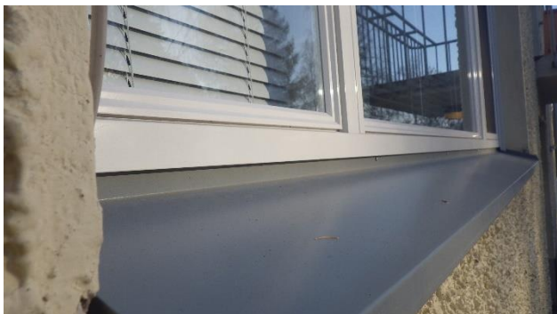
Kuva 23. Vuonna 2012 uusittujen ikkunoiden kunnossa ei havaittu puutteita.
