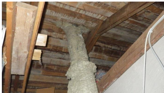
Kuva 59. Viemärin tuuletusputki tuotu vesikatolle.
