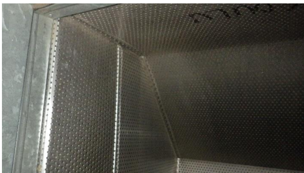
Kuva 89. Jakokammiossa reikäpellitettyä mineraalivillaa.
