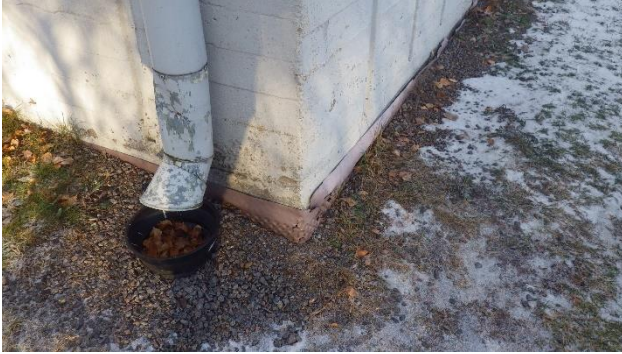
Kuva 9. Sadevesijärjestelmää parannettu vuonna 2012.
