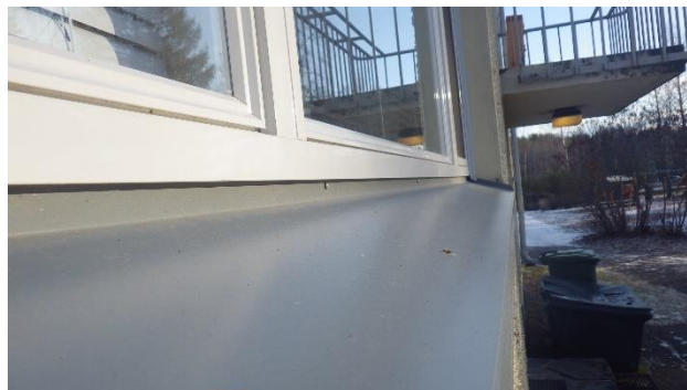
Kuva 24. Vuonna 2012 uusittujen ikkunoiden kunnossa ei havaittu puutteita.
