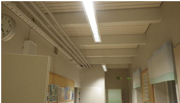
Kuva 46. Alkuperäisellä osalla laattapalkistoa.
