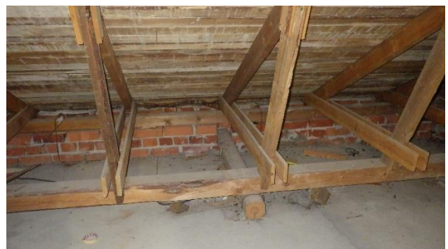
Kuva 57. Yläpohjatile tuulettuu räystäsrakojen kautta.
