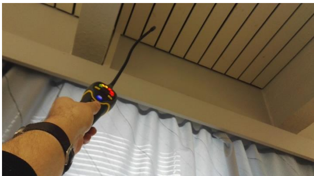
Kuva 104. Laskettaessa merkkiainetta tilan B206 (MA1) välipohjaan havaittiin merkkiaineen vuotavan tilaan B108 puolelle.
