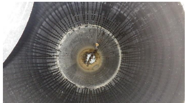
Kuva 8. Salaojat asennettu vuonna 2012.
