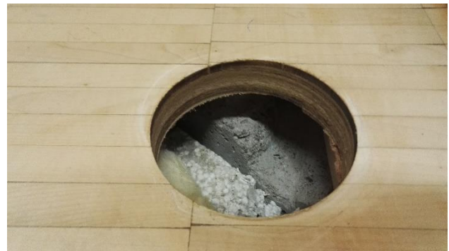
Kuva 45. AP-RT3, liikuntasalin alapohja betonilaatan päälle rakennettu koolattu puurakenne. Materiaalinäytteessä ei todettu mikrobikasvua, laatan ja eristeen välissä rakennusmuovi.
