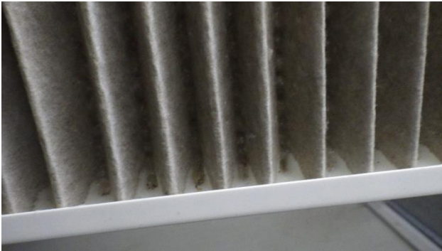
Kuva 82. Tuloilmasuodatin likainen.
