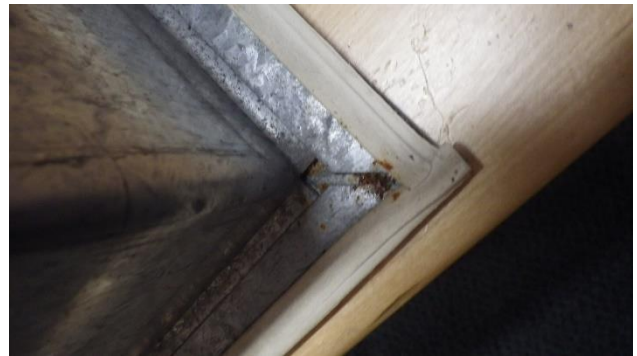
Kuva 67. Tarkastusluukussa ruostetta.
