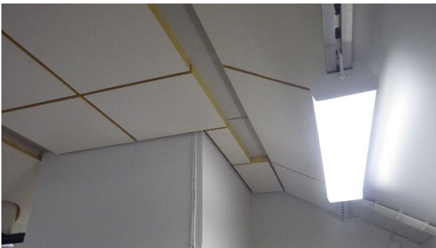
Kuva 100. Metallityöluokan sisäkatossa avoimia mineraalivillapintoja.
