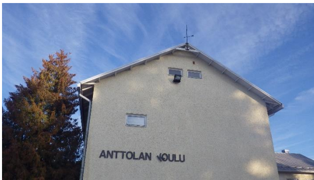
Kuva 50. Alkuperäisten rakennusosien kattomuotona harjakatto.
