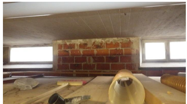
Kuva 49. Teknisen tilan yläpuolella välipohjarakenne paikallaan valettu tb-laatta, jonka päällä puukoolaus.
