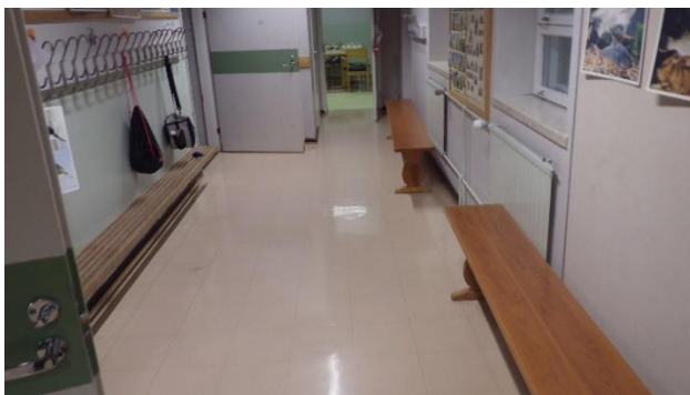
Kuva 90. Koulun tiloissa osin alkuperäinen vinyylilaattalattia.
