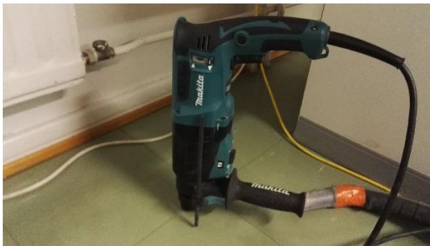
Kuva 44. AP-RT1, tila B107, ulkoseinän vierustalla tyhjä, kaivamaton tila betonilaatan alla. Rakenteesta otetusta mineraalivillasta ei todettu poikkeavaa mikrobikasvua.
