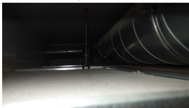
Kuva 97. Alakattotilat puhtaat korjatulla siivellä. Lka-huone A204.
