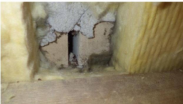
Kuva 33. Konvektiovirtausten aiheuttamaa tumumista tuulensuojavillan ulkopinnassa. US-RT6.
