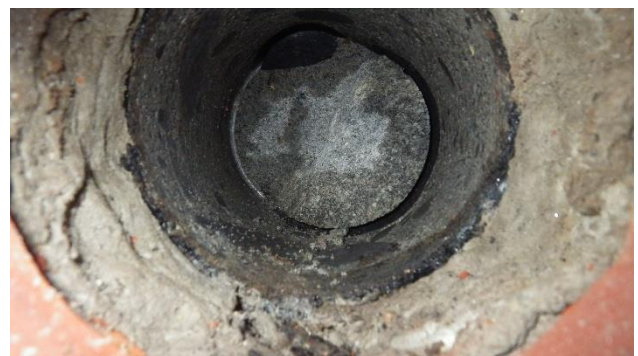
Kuva 10. Ulkoseinärakenne todettiin vastaavaksi US-RT1 kanssa.
