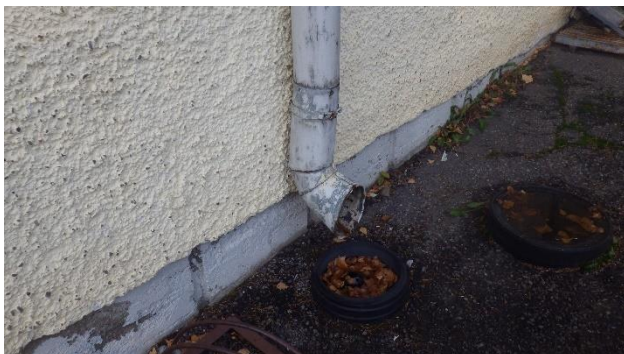
Kuva 7. Sadevesijärjestelmää parannettu vuonna 2012.
