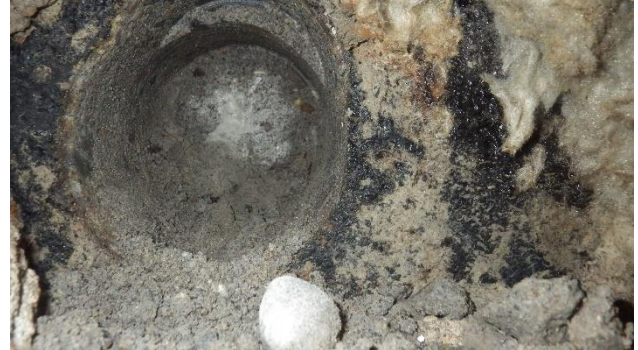
Kuva 5. Pikisively ei ole yhtenäinen.
