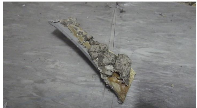
Kuva 41. Tilan C110 muovimatossa pistävä haju vesivuotoalueella.
