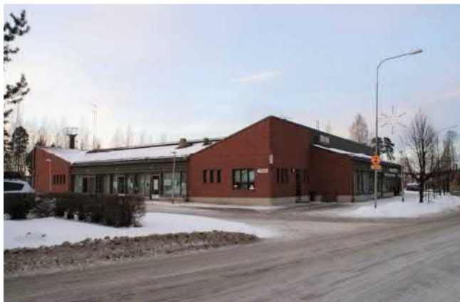
Kuva: Rakennuksen eteläsivu Kuusitieltä.
