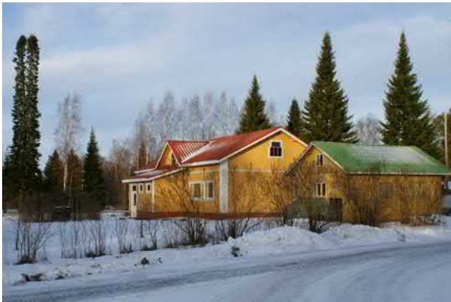
Kuva: Päärakennus ja 1950-luvun ulkorakennus. Vanhat talousrakennukset on purettu.
