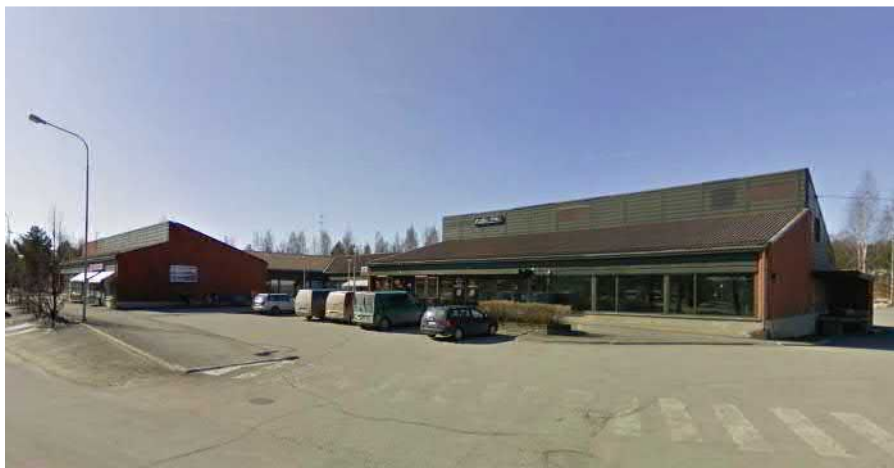
Kuva: Entinen linja-autoasema. /Google-kuva.
