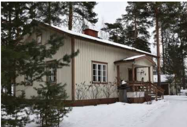
Kuva: Asuinrakennuksen ikkunat on uusittu n. 1970-luvulla.
