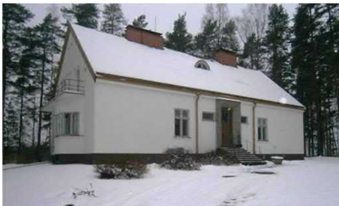
Kuva: Talon tien puoleinen julkisivu.
