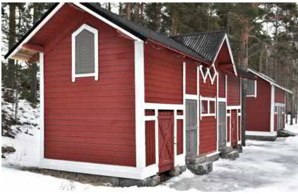
Kuva: Vahtituvan ulkorakennuksia, etualalla aitta-liiteri -rakennus ja takana navetta-ulkohuone.
