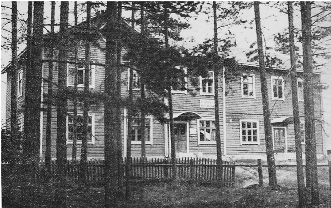
Kuva: Vanha kunnantalo noin vuonna 1932-33, jolloin se oli laajennettu nykyiseen kokoonsa. / Kuva julkaisusta Punkaharjun kunta vuosina 1924-28 ja 1929-33.
