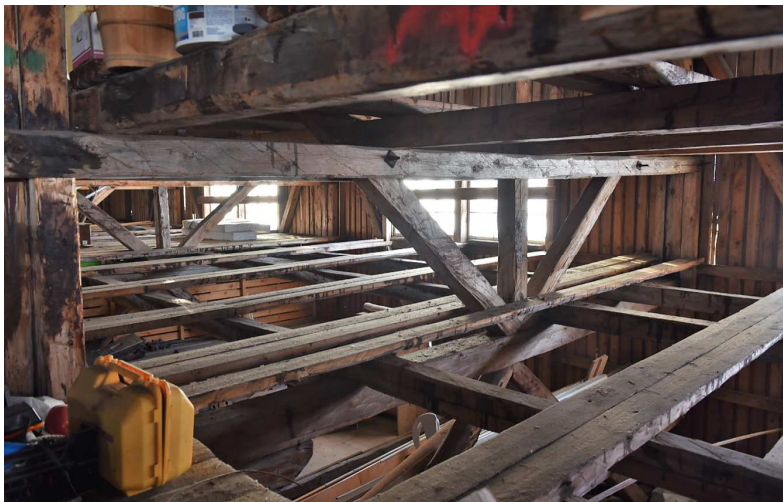
Kuva: Rakennuksen hirsirakennetta. Tasanteet eivät ole kauttaaltaan umpinaisia.
