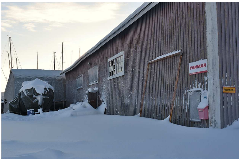
Kuva: Järvenpuoleiselle sivulle on avattu sisäänkäynti ja ikkuna myöhemmin rakennettuun toimistoon. Ikkunoita on peitetty levyillä.
