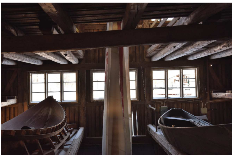
Kuva: Pohjoispäädyssä oleva aukko, jonka kautta veneitä nostettiin. Aukossa ei ole alkuperäistä nostolaitetta.
