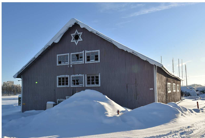
Kuva: Pohjoispääty ja länsisivu.
