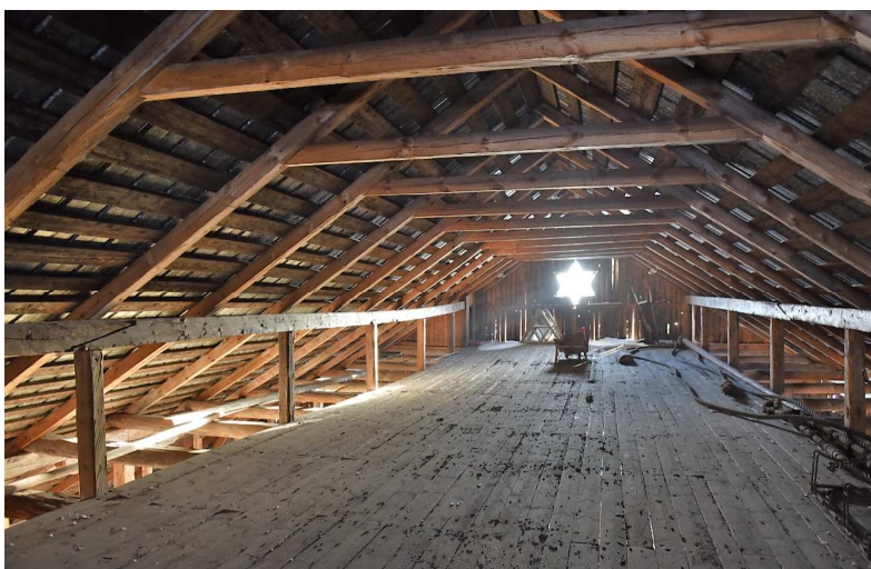
Kuva: Vinttikerros. Lankkuportaat sijaitsevat rakennuksen pohjoispäässä, lähellä nostoaukkoa.
