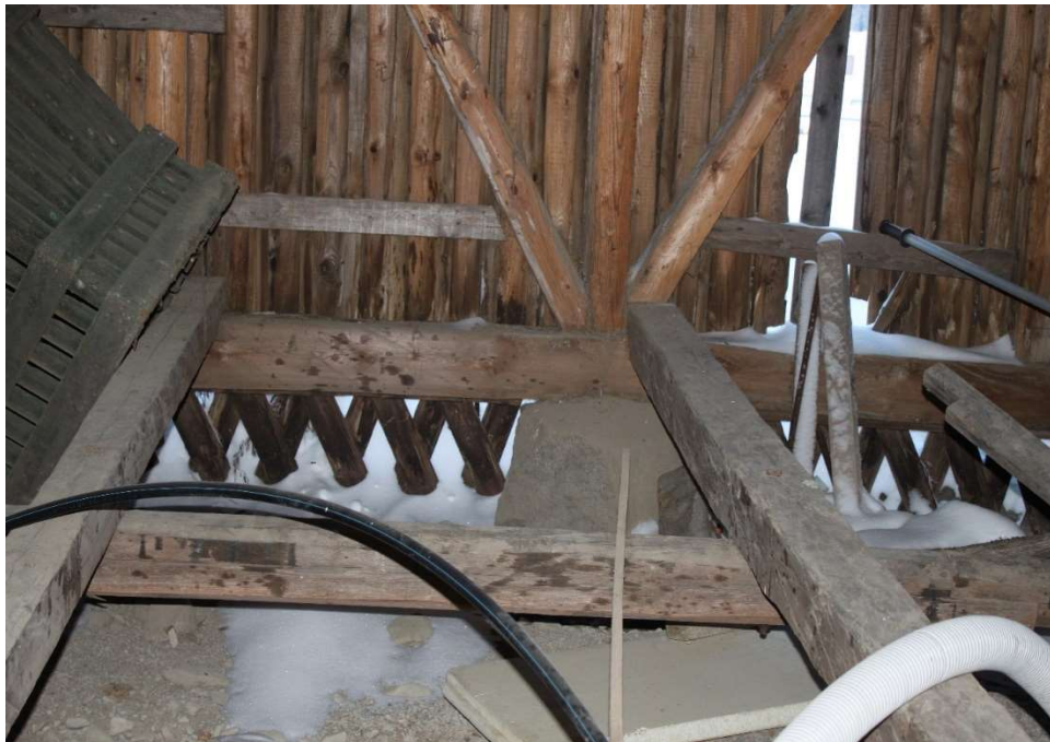
Kuva 1. Peruskivi kantaa seinän pystyrakenteet.
