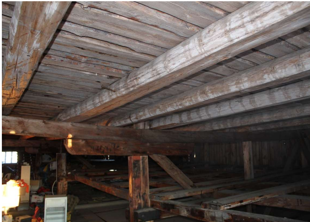
Kuva 3. Välipohjapalkistoissa taipumia
