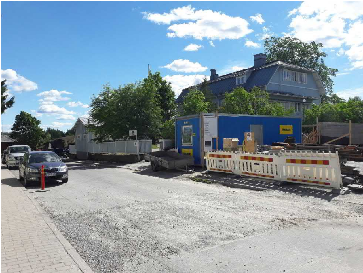
Metsänhoitajan talo Akselinkadulta (17-9). Oikealla uudisrakennuksen työmaa (17-8).
