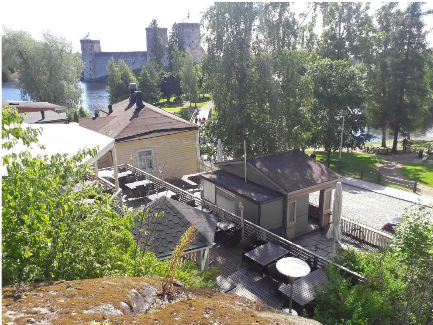
Ravintola Linnakrouvin päärakennus ja kioskirakennus (17-17)
