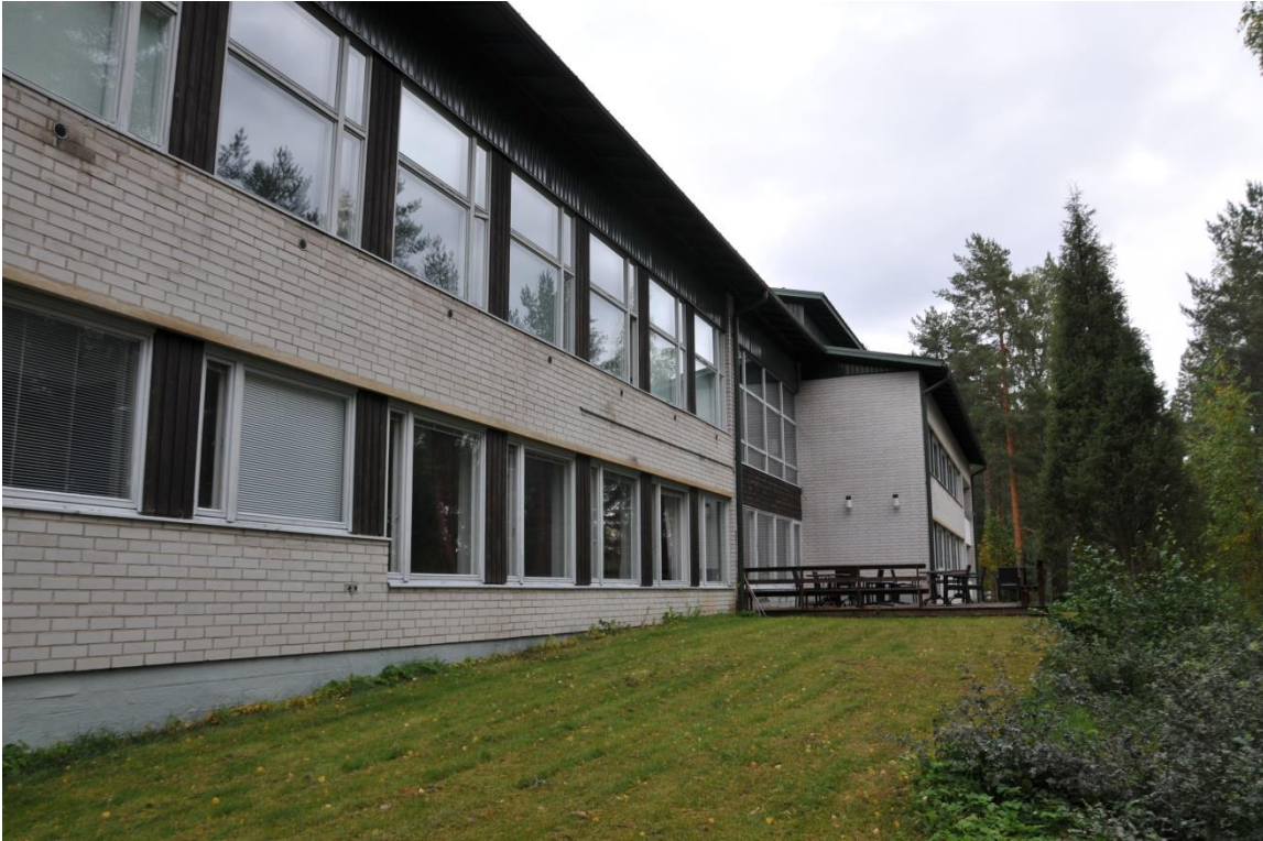
Kuva. Rannan puoleinen julkisivu
