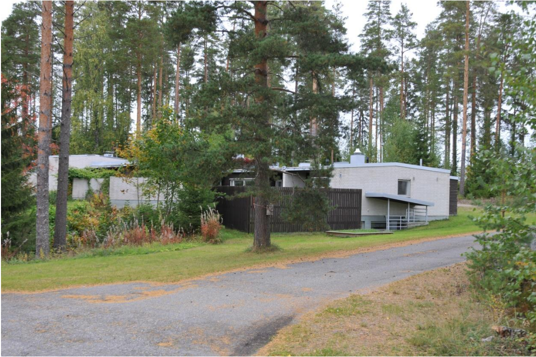
Kuva. Opettajien asunnot päärakennukselta päin
